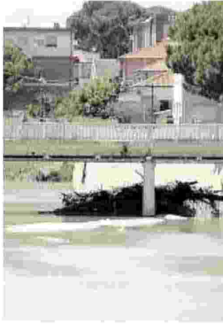
Rami sotto un ponte sul Misa
