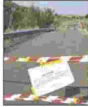
La strada interrotta
