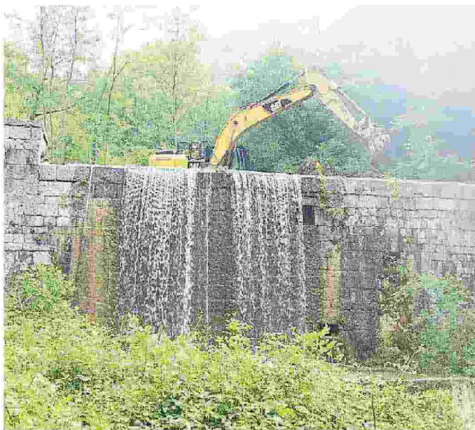
Lavori su una delle briglie lungo l'Ombrone
