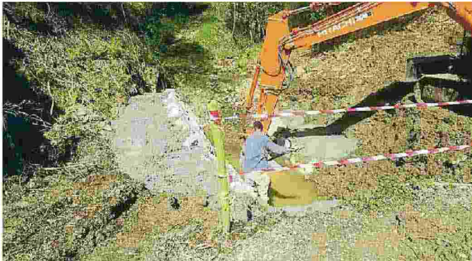
I lavori in corso sul Fosso delle Sponde
