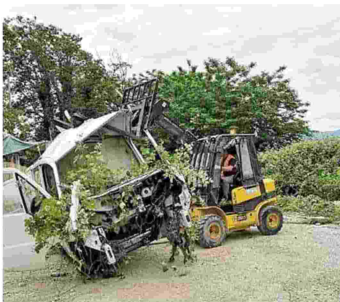
I mezzi del cantiere comunale in azione per ripulire l'area nei pressi del campo nomadi. I lavori dureranno ancora qualche giorno
