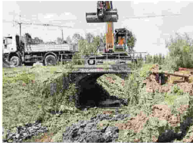
Ieri sono partiti i lavori di demolizione del ponte sul Ceresone
