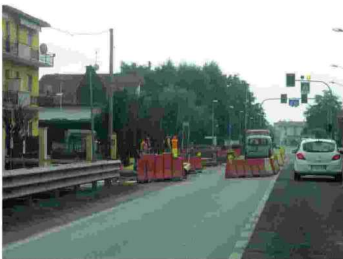
VIA TREVIGLIO Il cantiere in corso per il primo lotto di tombinatura della roggia
