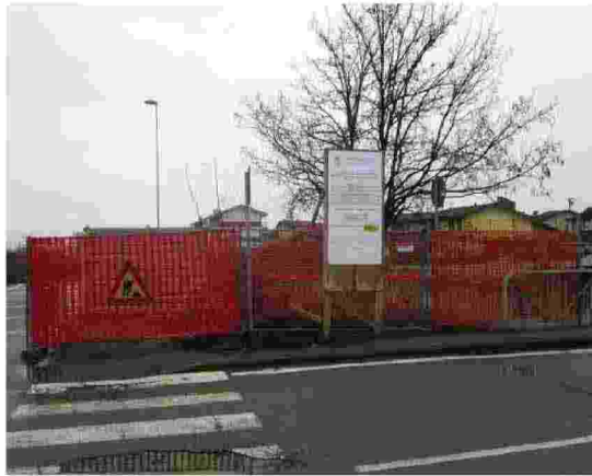
CANTIERE Il terreno comunale di via Padre Anelli dove sorgerà uno dei pozzi
