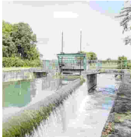
Il salto d'acqua del canale Molinella
