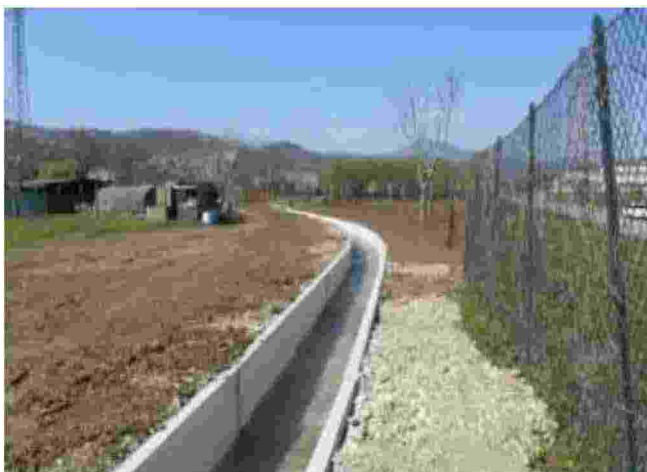
La posa della canalina per il deflusso della roggia dei Lecchi
