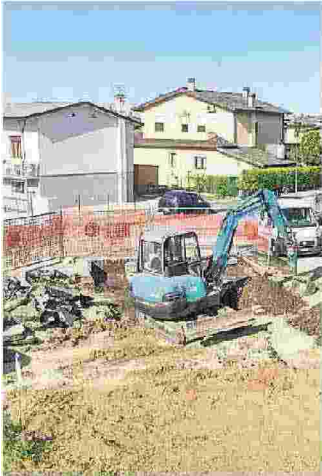
Il cantiere di via Bacchiglione
