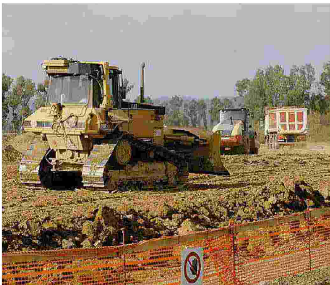
I lavori in corso nel cantiere (foto Giancarlo Grassi)
