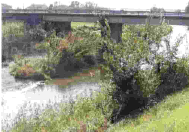
La roggia Feriana di Cresole su cui sono previsti degli interventi
