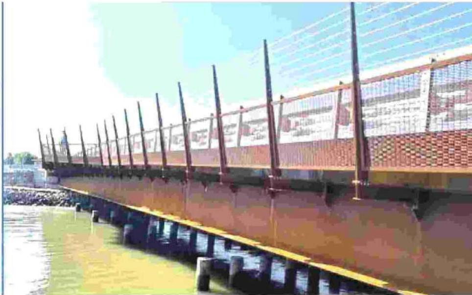
VIABILITÀ Il nuovo ponte è stato realizzato in campata unica in acciaio.
