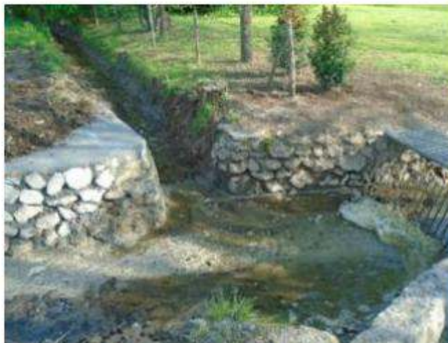
L'intervento realizzato lungo la roggia da Marano a Schio. G.A.R.
