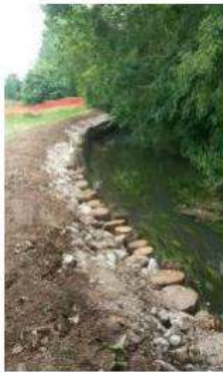
I lavori sulla roggia Seriola
