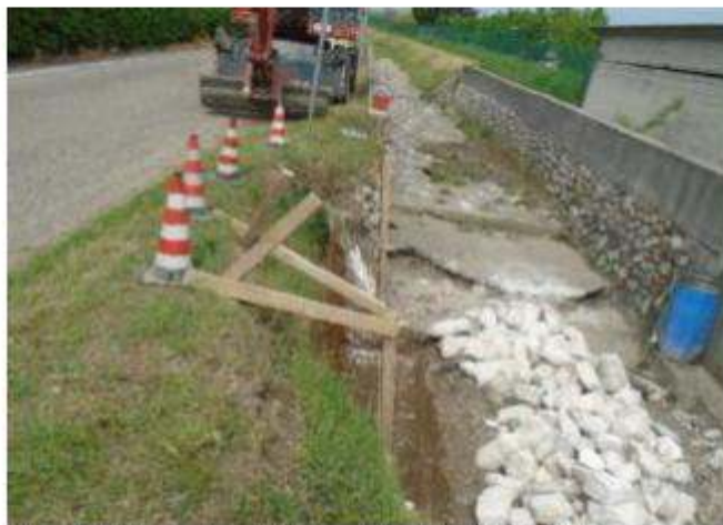
I lavori di sistemazione della roggia in via Prà Novei a Thiene. G.A.R.
