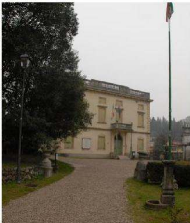
Per Villa Romani, a Sona, lavori antisismici FOTO PECORA
