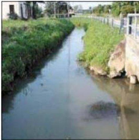
IN SICUREZZA Il canale Rio Venise
