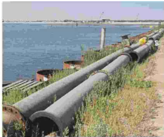
I tubi da cui passa il materiale estratto dalla draga sul fondo della pialassa
