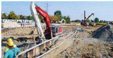
Il cantiere per costruire lo scolmatore Fossetta
