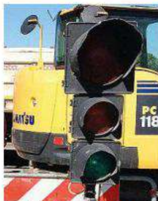
Lavori di asfaltatura in corso
