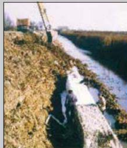
RISCHIO Il rifacimento di alcuni argini in provincia di Rovigo
