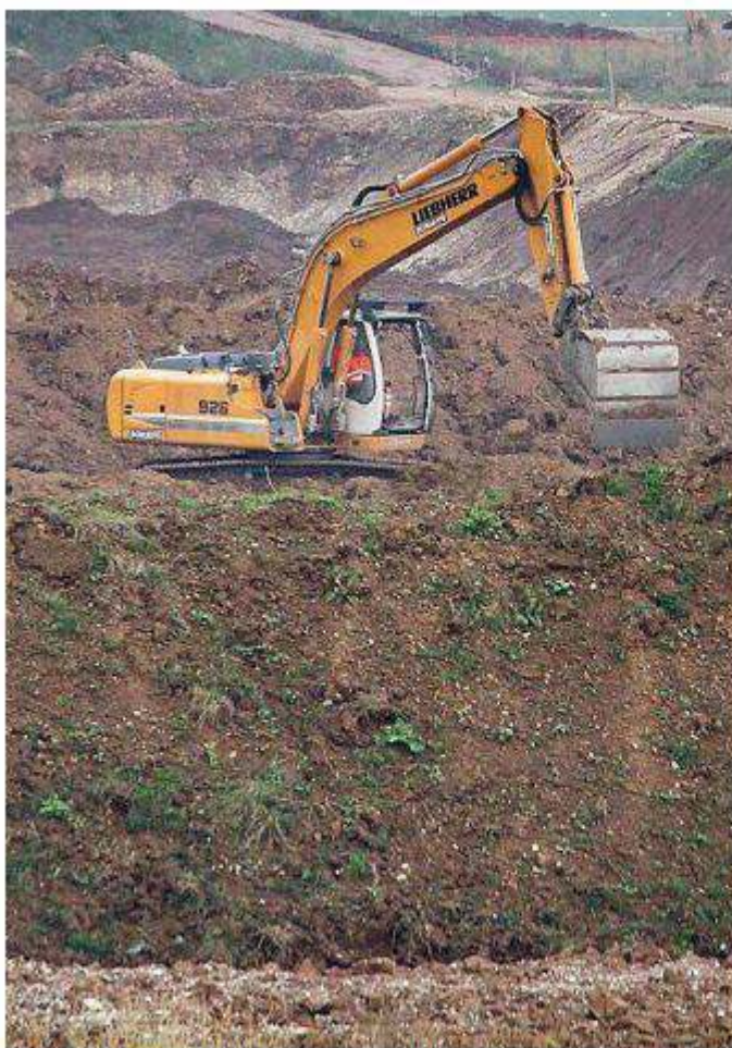
L'area di Caldogno dove si sta realizzando il bacino di laminazione
