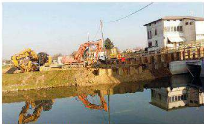
I lavori per la nuova idrovora di Brentelle
