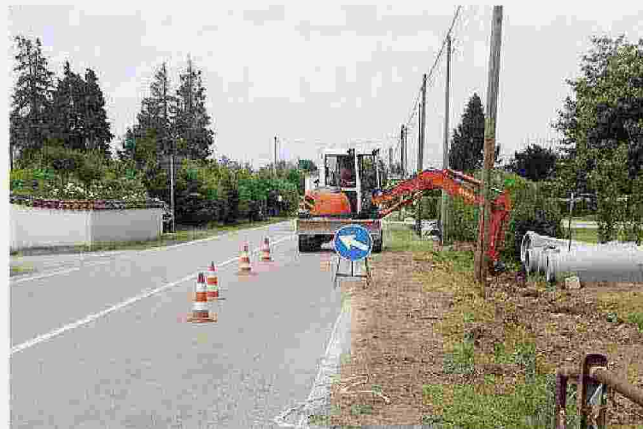
Lavori di tombinamento di un canale a Santa Lucia
