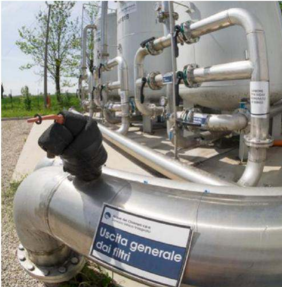
Acque del Chiampo ha installato i filtri a carboni attivi nell'acquedotto. FOTO ARCHIVIO
