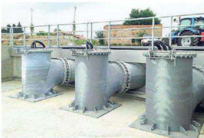
Le idrovore di Palù Grande hanno una portata di 200 mila litri al secondo
