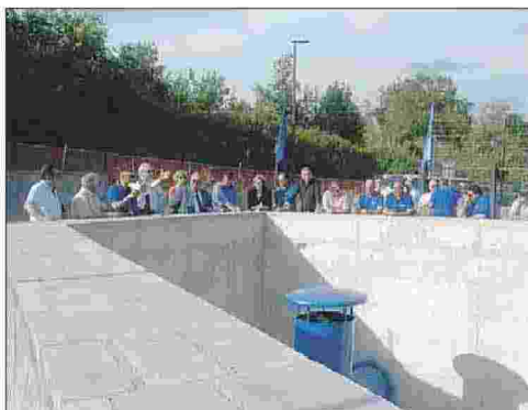
La stazione di sollevamento Il prefetto e cinque sindaci hanno partecipato alla visita guidata dell'impianto nel territorio di Baschi
