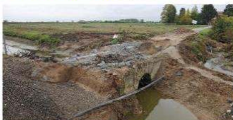
Il cantiere aperto sul ponticello dello scolo Anson DIENNEFOTO
