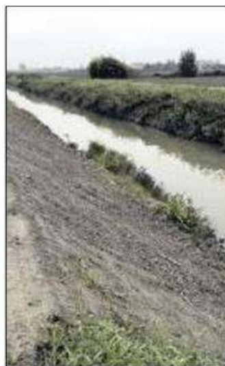
VIA TRIESTE Ripristino effettuato
