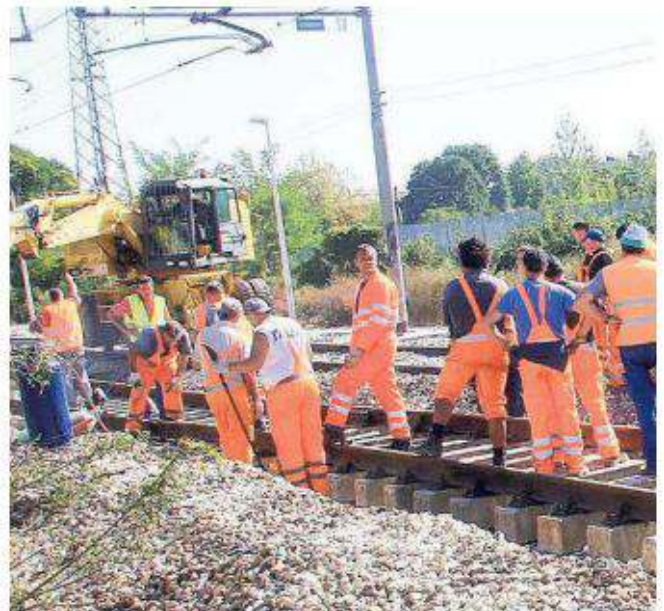
I lavori per ripristinare la linea dopo l'incidente
