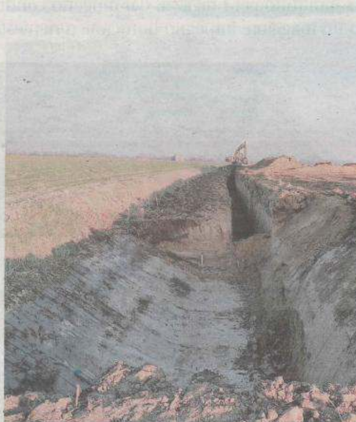
Ruspe in azione per la realizzazione del by pass
