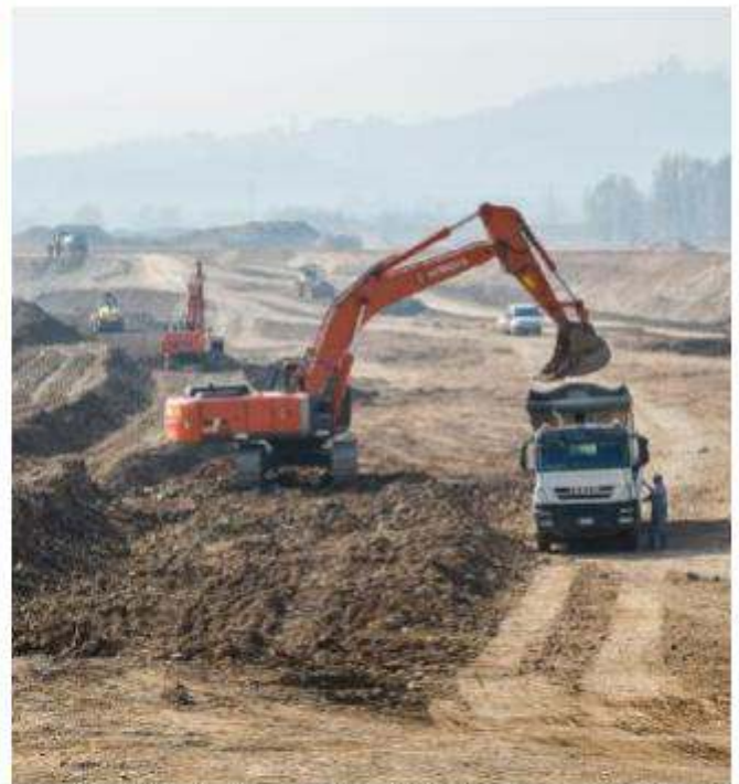
Il cantiere del bacino di laminazione di Trissino. FOTOSERVIZIO MASSIGNAN
