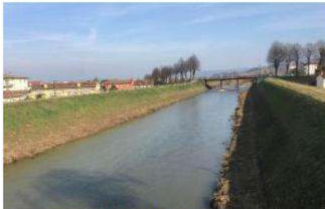
Ecco come si presenta l'alveo del Guà dopo i lavori. L.Z.
