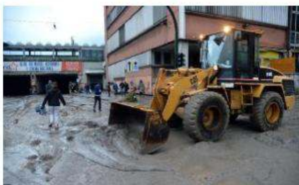
Lavori di ripristino dopo un'alluvione
