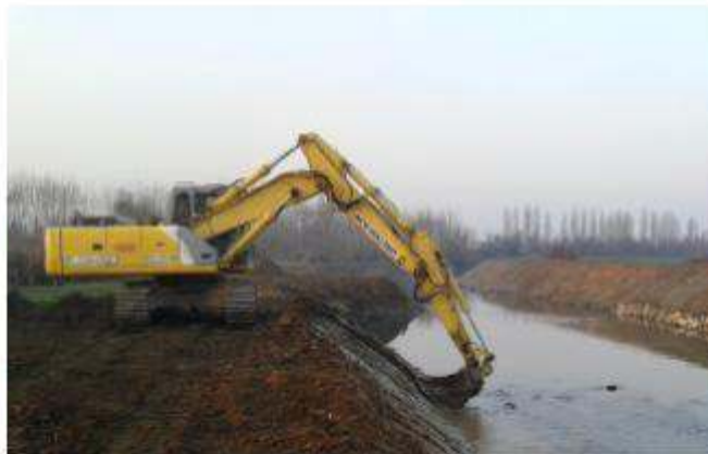
Lavori sull'argine del Tesinella a cura del Consorzio Brenta. A.F.R.
