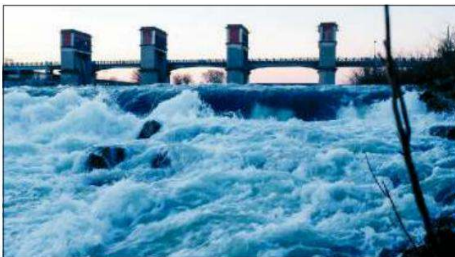
"BRIGLIE DI STRA" Le strutture rappresentano un elemento fondamentale per la sicurezza idraulica della Riviera
