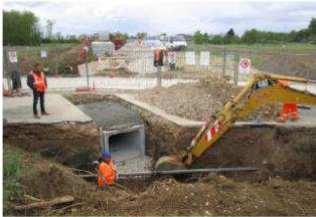
Il posizionamento degli scolarari in cemento. BONATO
