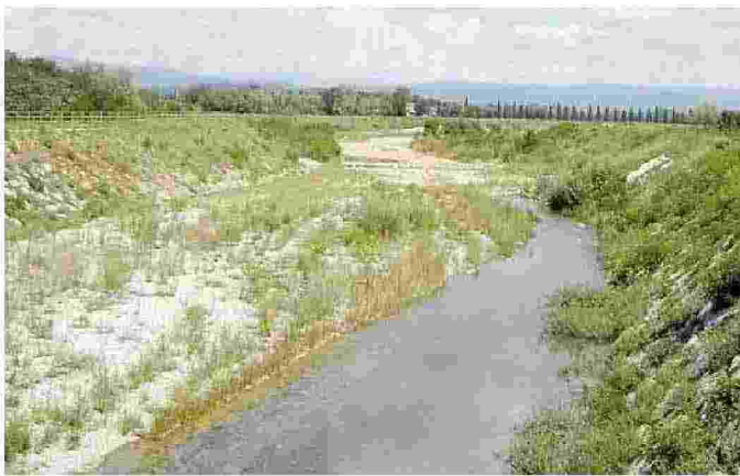
Il torrente Versa: è finanziato il miglioramento del deflusso delle acque
