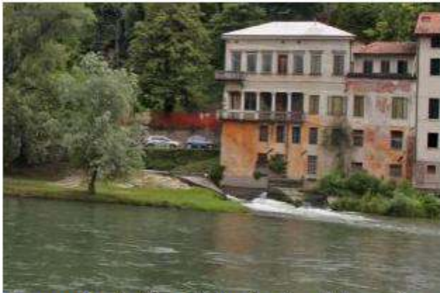
Il luogo com'è oggi: qui è prevista la realizzazione della centralina
