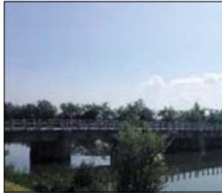
PORTO VIRO Il ponte Gramignara
