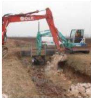
I lavori lungo il Fossiello. L.Z.
