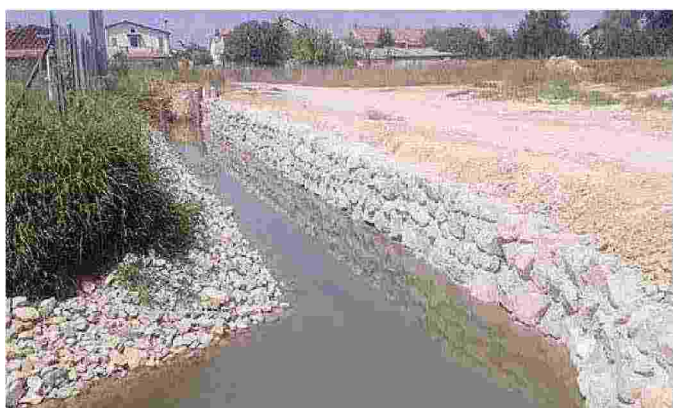
La canaletta Veronese, intervento decisivo per la sicurezza idraulica di Tavo
