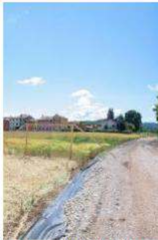
Cantiere per il vallo in Ca' Tosate
