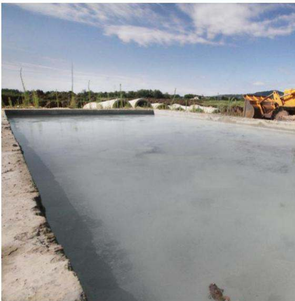
Il cantiere a Caldogno per la realizzazione del bacino di laminazione delle piene del Timonchio
