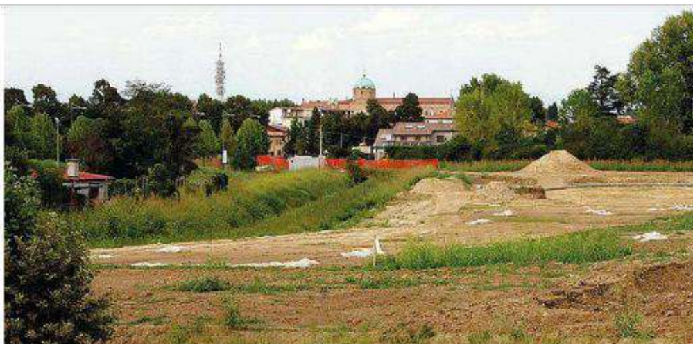
L'area di via Gerardo dove sono in corso i lavori di realizzazione del nuovo bacino di laminazione (FOTO BIANCHI)
