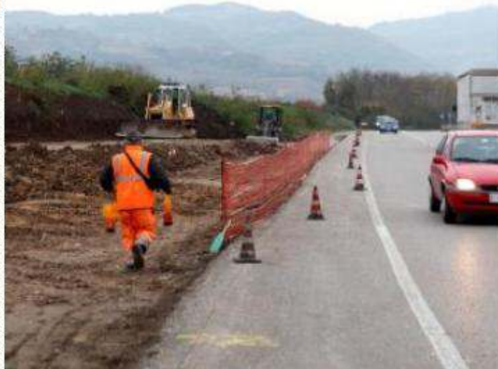
Il cantiere che porterà alla realizzazione del bacino di Colombaretta
