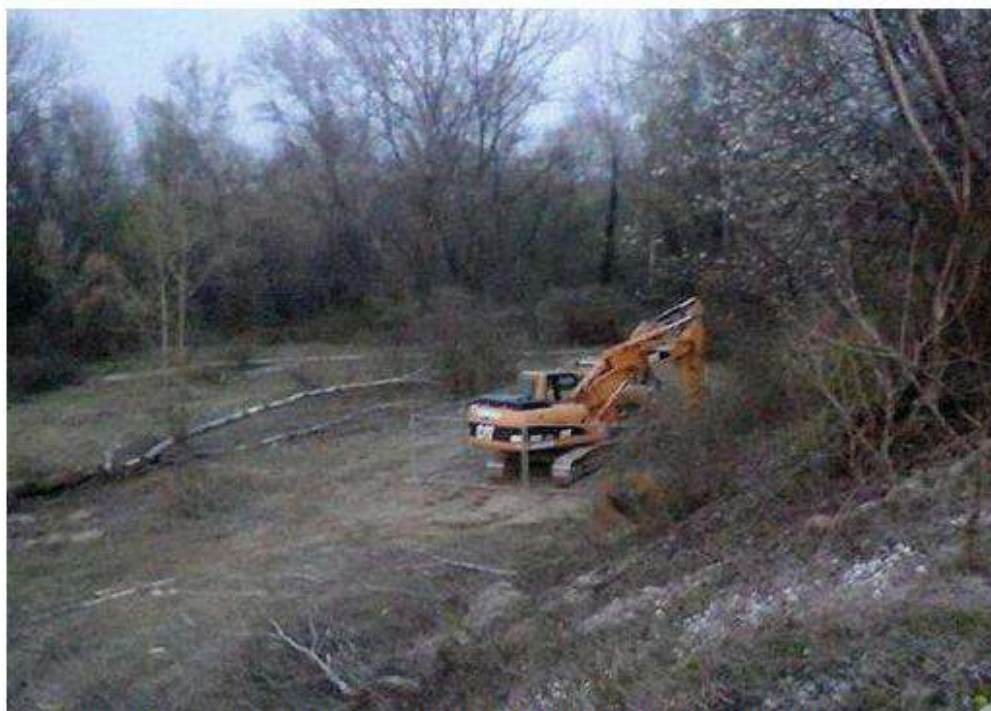
Le ruspe in azione nell'area golendale del Brenta per predisporre i punti di escavazione dei nuovi pozzi
