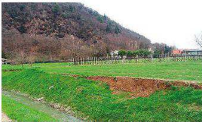
Il tratto di argine dello scolo Rialto crollato fra Teolo e Torreglia
