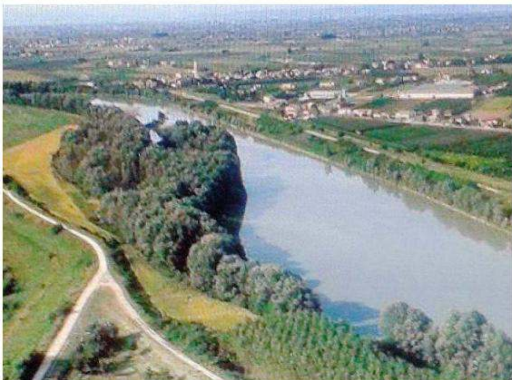
Il punto del corso dell'Adige dove dovrebbe essere realizzata la diga con un salto di oltre cinque metri
