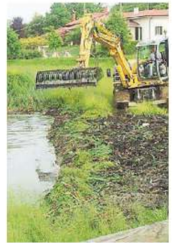
Lavori di manutenzione a uno scolo
