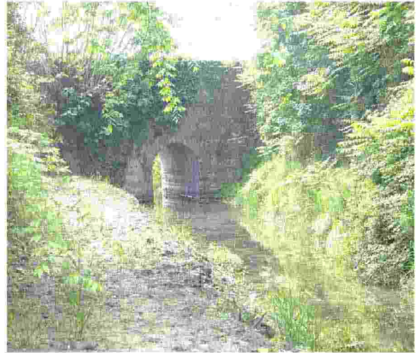
Fossa Toniola: migliorata sia dal punto di vista ambientale che irriguo
