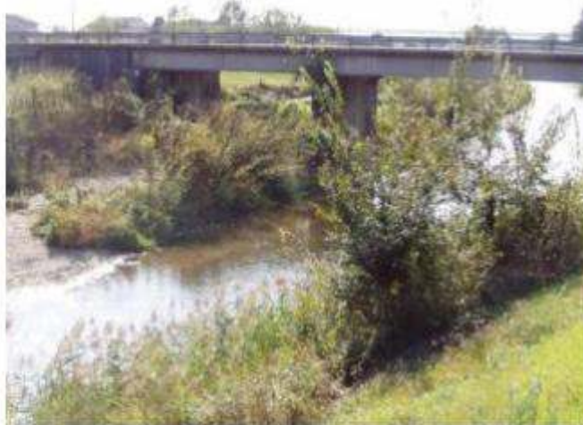
La roggia Feriana di Cresole su cui sono previsti degli interventi
