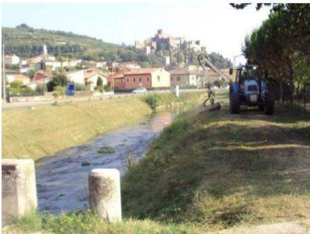
Intervento di manutenzione lungo il Tramigna in prossimità dell'Adige
