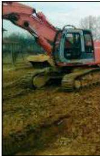
I lavori in Valle Tagli di Eraclea
