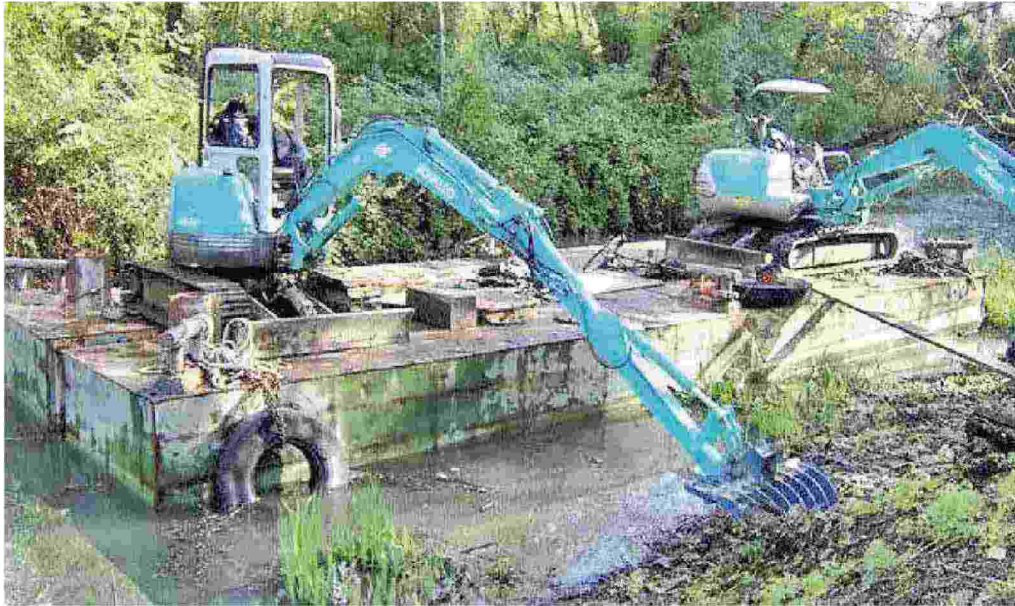
Le macchine del Consorzio di bonifica al lavoro
