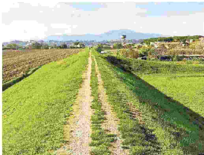
La zona che sarà interessata dagli interventi
