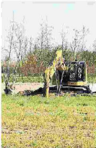
Una ruspa in via Sabbioncello
