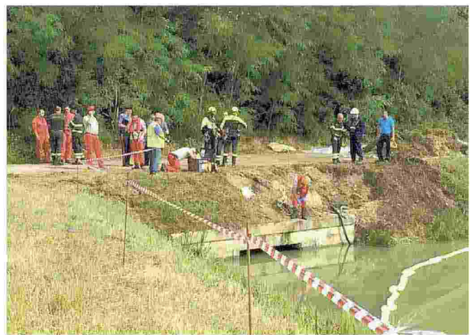
Vigili del fuoco e tecnici cercano di arginare lo sversamento del gasolio nell'Idrovia (foto Vigili del fuoco)
