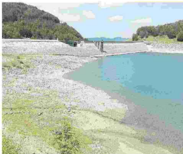
L'impianto idroelettrico del Lagastrello. La Bonifica propone di usare gli invasi Enel per l'irrigazione dei campi
