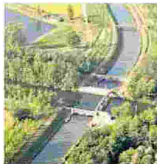
Un tratto del Canale Cavour
