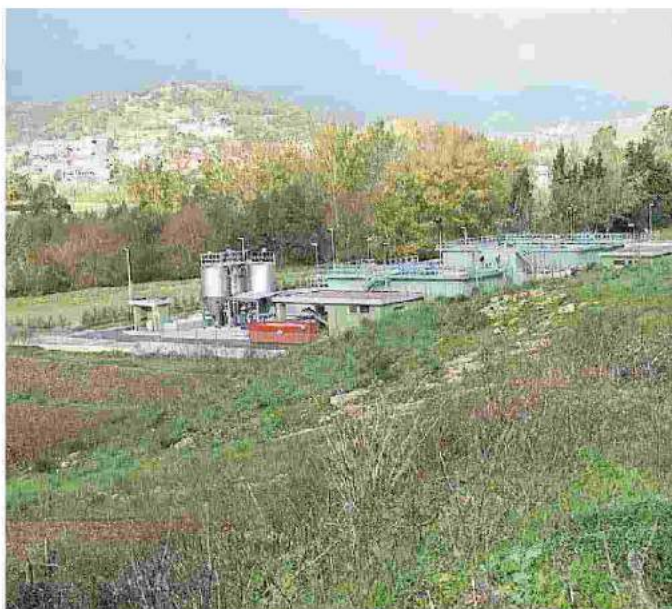
L'impianto di depurazione nell'area di Curcuris
