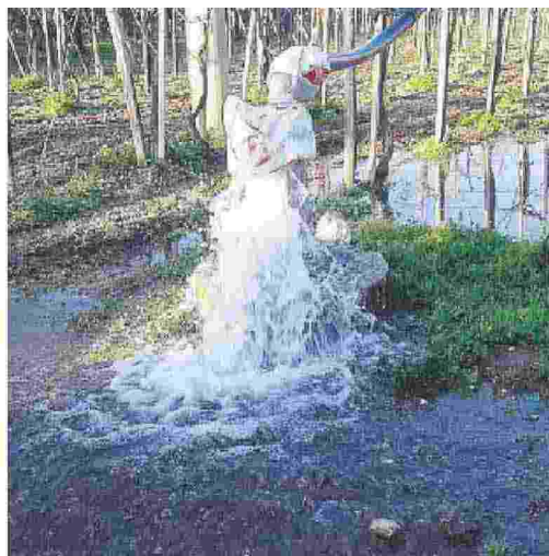
I furti agli impianti provocano allagamenti
