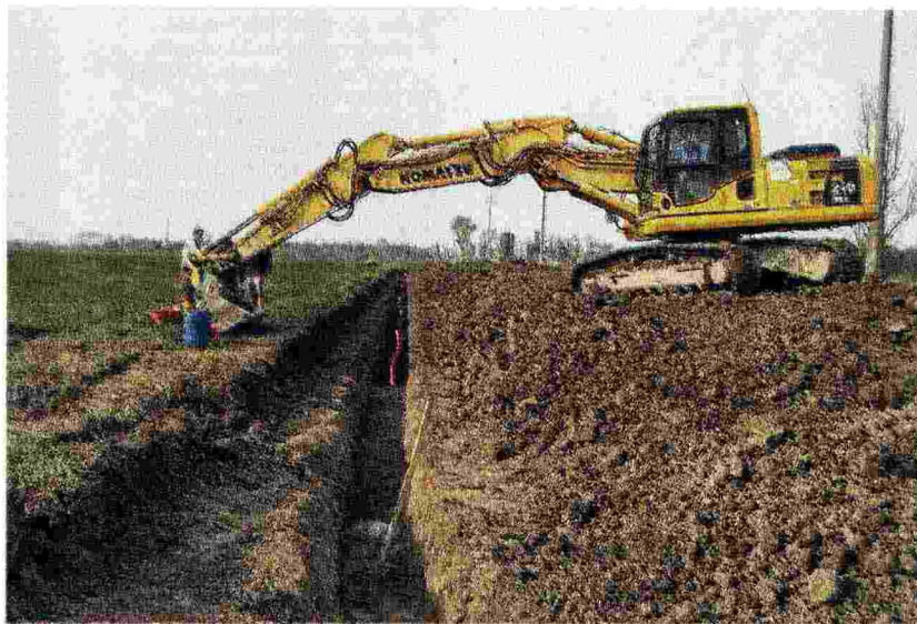
Canale Naviglio Nuovo Le fasi di scavo e di posa del cavidotto per la corrente elettrica.
