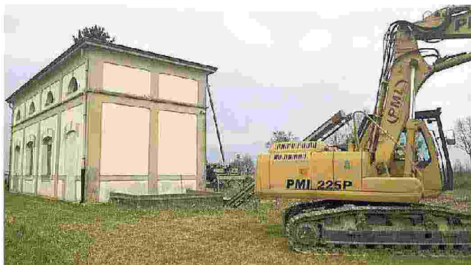
Lavori all'idrovora di Concordia
