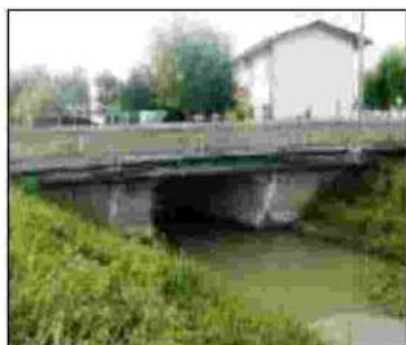
RESTAURO Riqualificazione anche per il ponte Ca' Bianca
