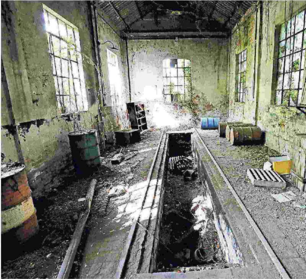
L'interno della stazione-officina rimasta nascosta per anni
