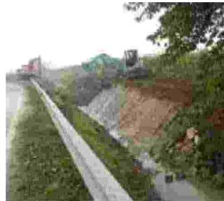
Una fase dei lavori. ZONINI
