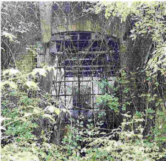
L'esterno dell'officina che si trova in Garzaia
